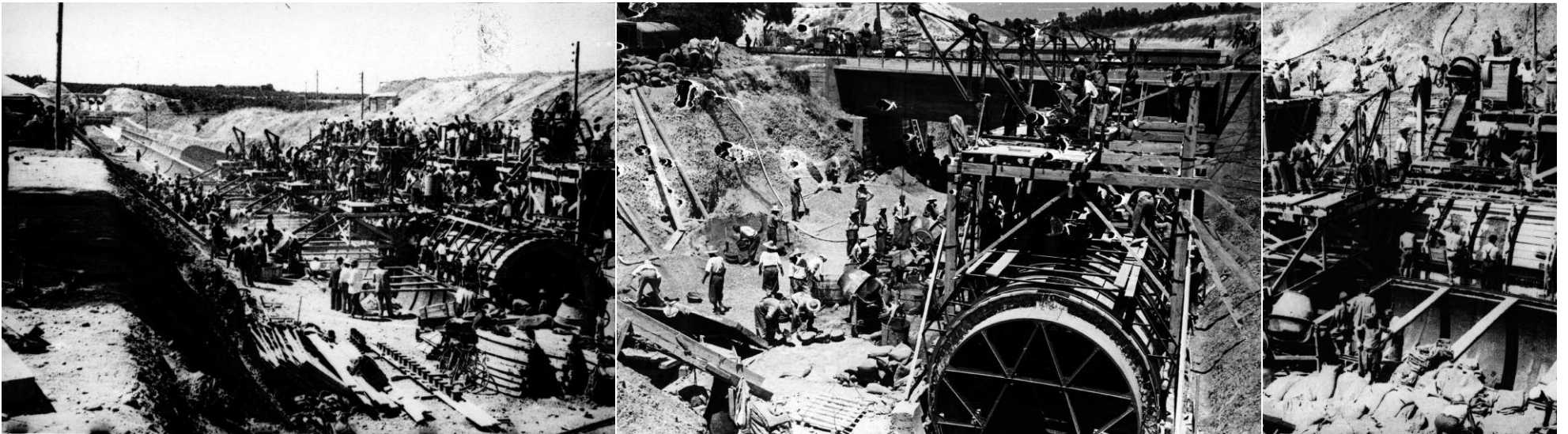
Construcción del canal del bajo Guadalquivir por presos políticos. 1940-1962.
